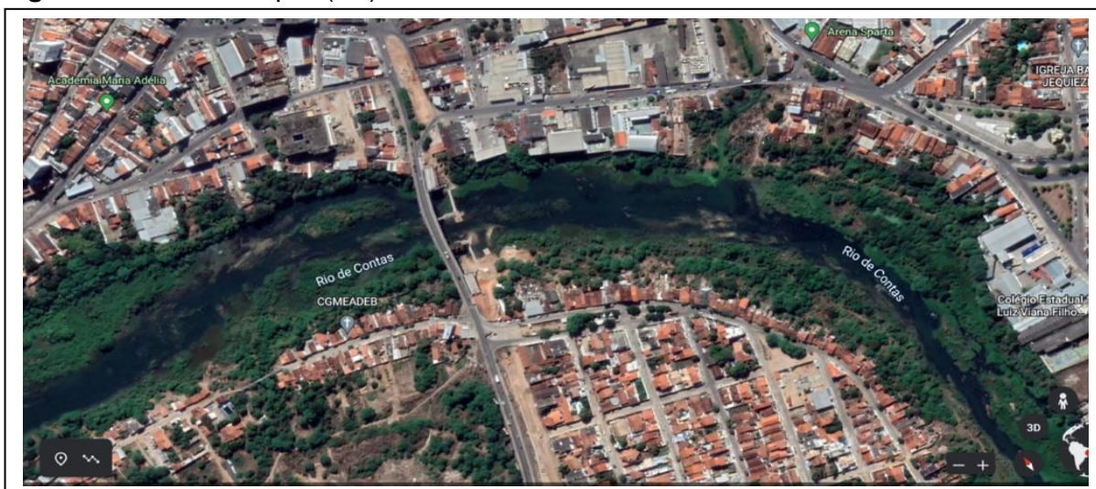
Figura 2: Ponte de Jequié (BA).
