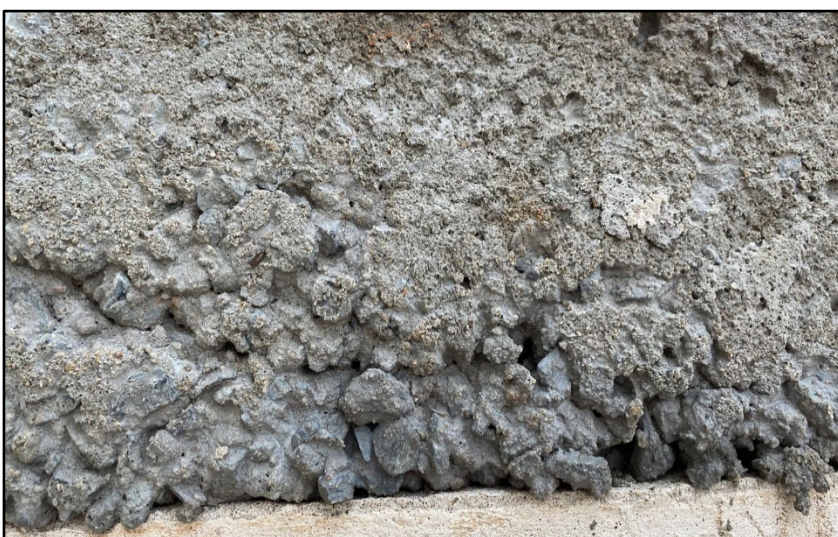
Figura 4: Concreto segregado
