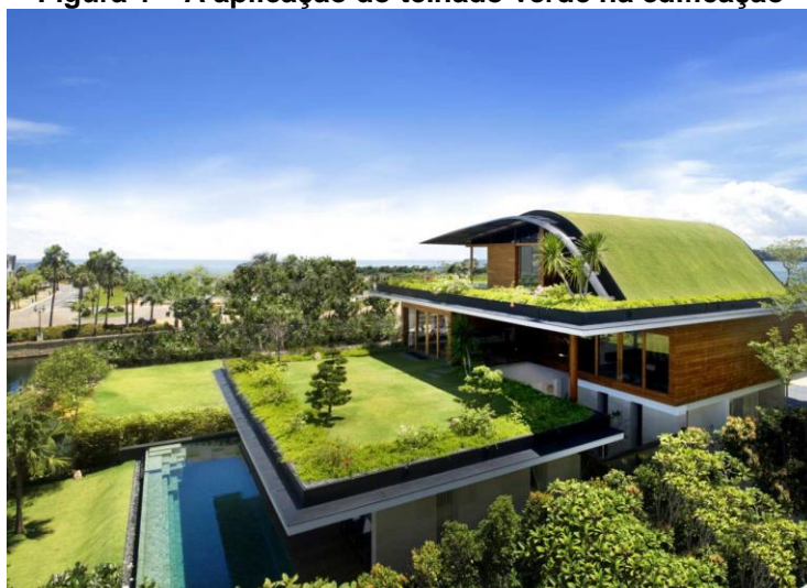
Figura 1 – A aplicação do telhado verde na edificação
